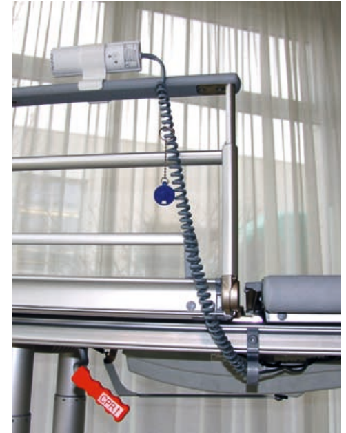
Verlegung des Handschalterkabels
